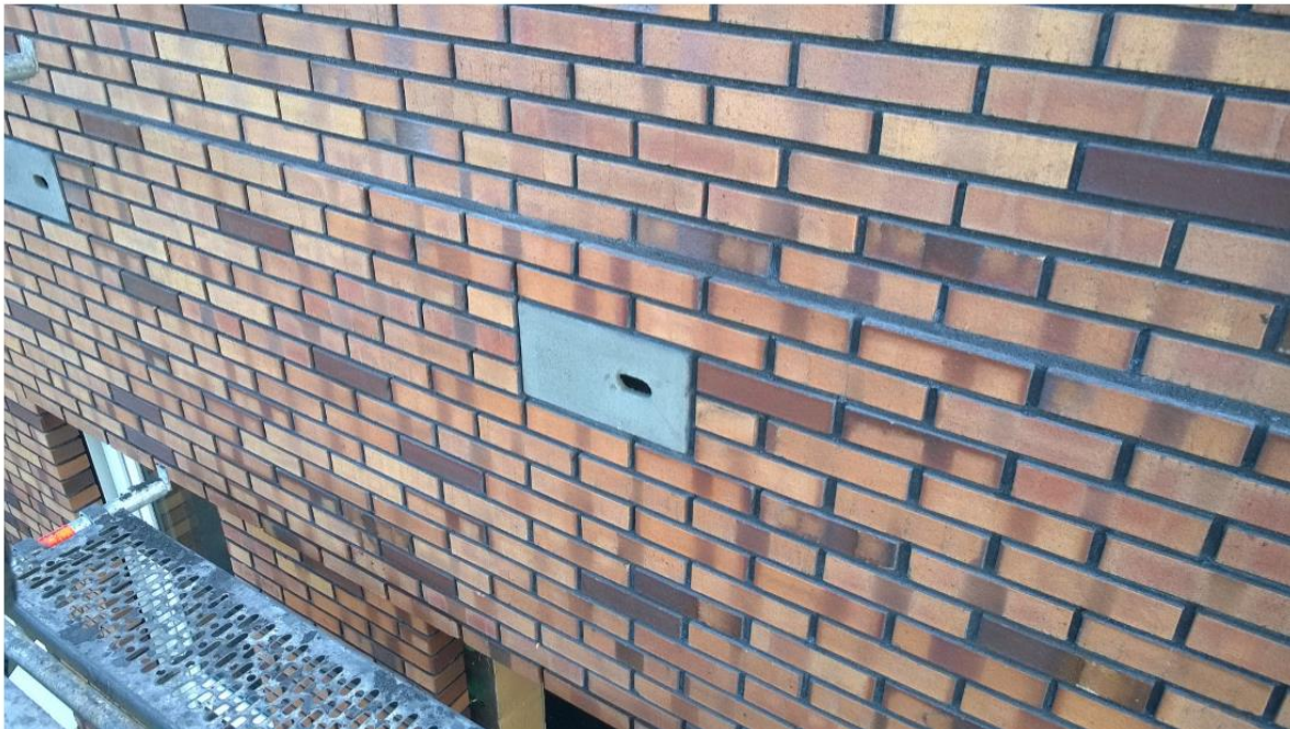
Trefkoel Paddepoel, inbouw nestkast Gierzwaluw op 50 m hoogte, 2 februari 2017
